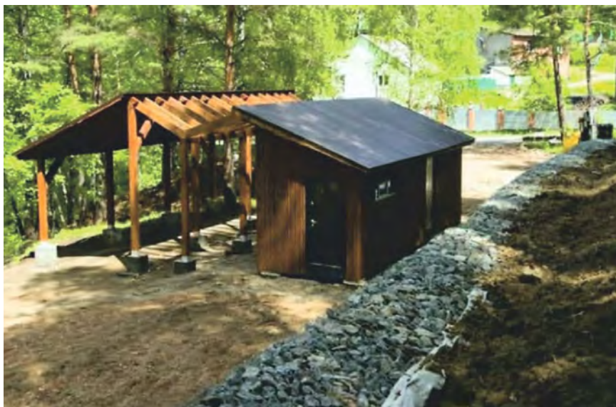
Благоустройство входа на терренкур.
