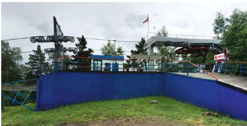
Обводная станция канатной дороги на г. Церковке.
