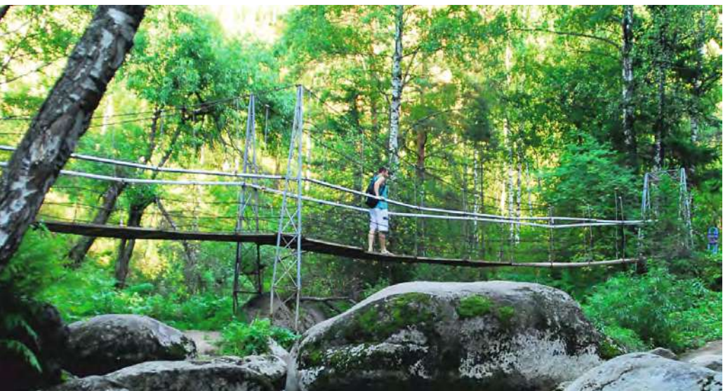
Подвесной мост через реку.
